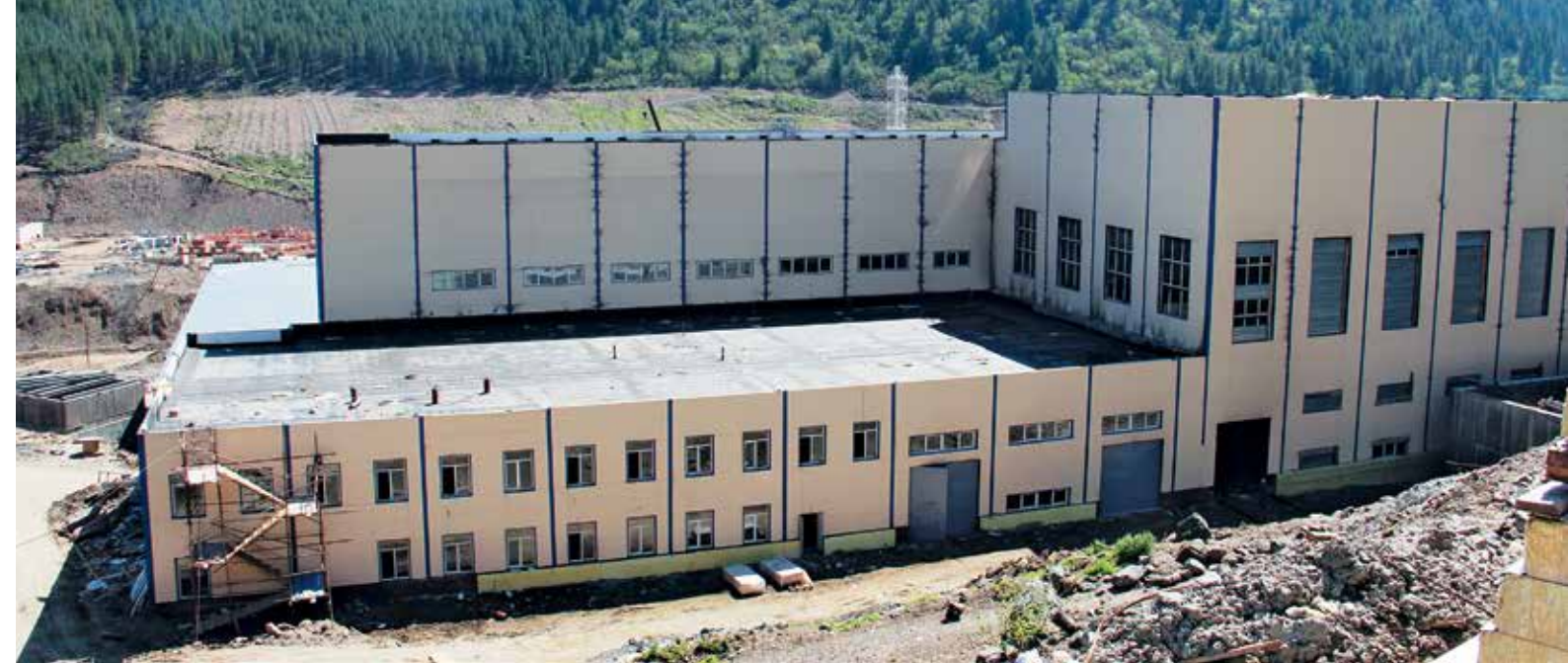
Кызыл-Таштыгский ГОК. Обоганительная фабрика
