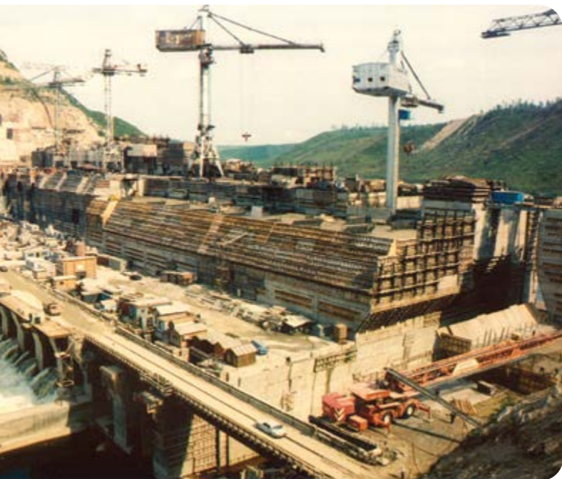
Строительство горных выработок Бурейской ГЭС
