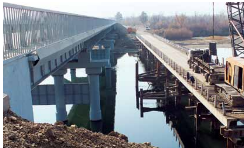
Постоянный автомобильный мостовой переход через р. Чикой
