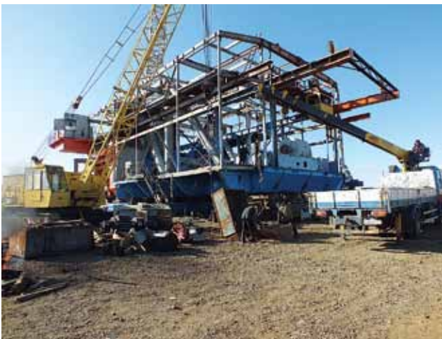
Монтаж шагающего экскаватора ЭШ-20/90
