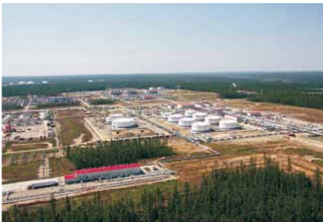
Центральный пункт сбора нефти
