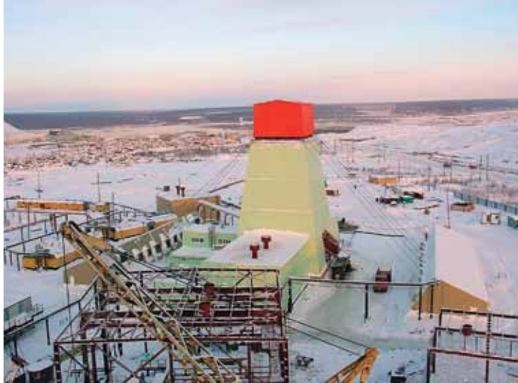
Строительство вентиляционного ствола на руднике «Удачный»
