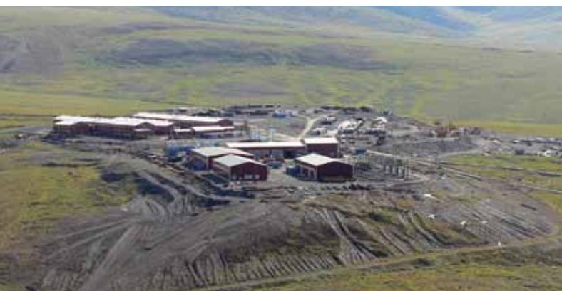
Вахтовый поселок на месторождении Майское
