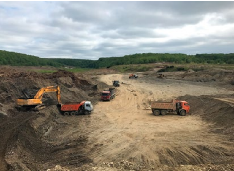
Добыча ПГС для строительства дороги
