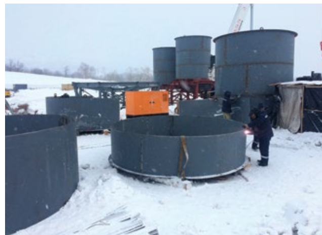
| Монтаж технологического оборудования
