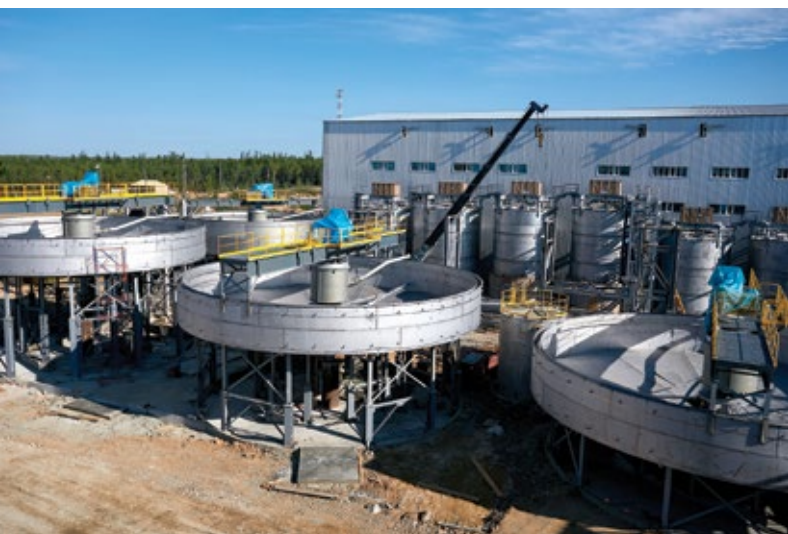
Строительные работы рядом с цехом фильтрации и нейтрализации Покровского АГК, 2017 год
