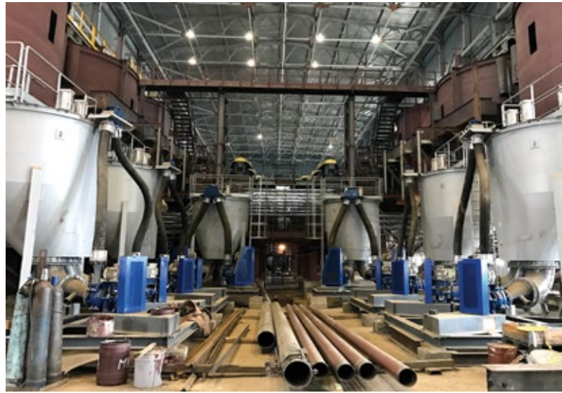
Строительные работы на флотационном комбинате Маломырского рудника, март 2017 года
