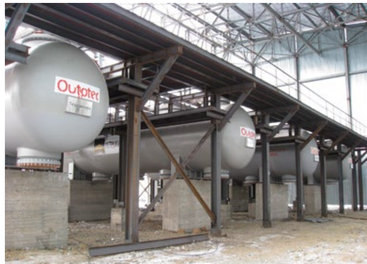
Автоклавы после установки на фундаменты, 2013 год
