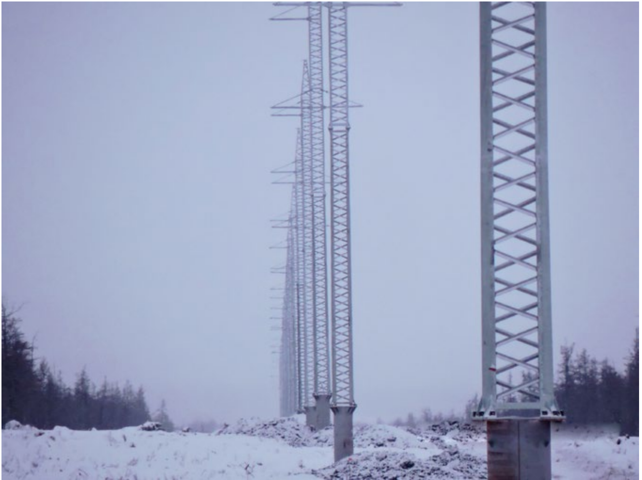
Высоковольтная линия БКП 1
