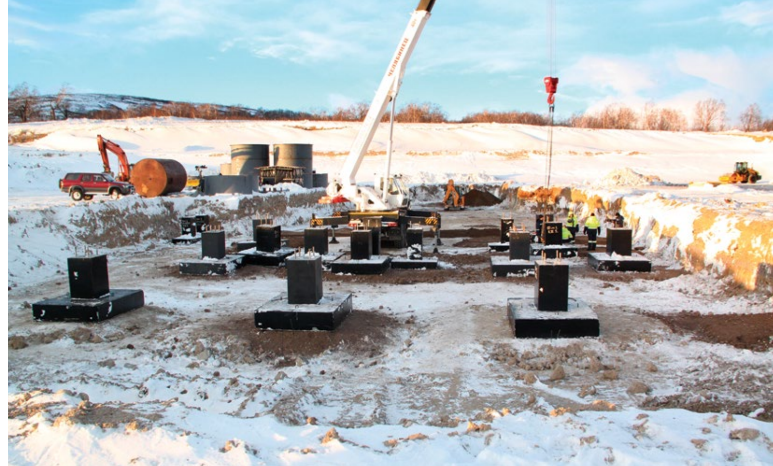
| Установка фундаментных блоков под ОПУ, ноябрь 2017 г.
