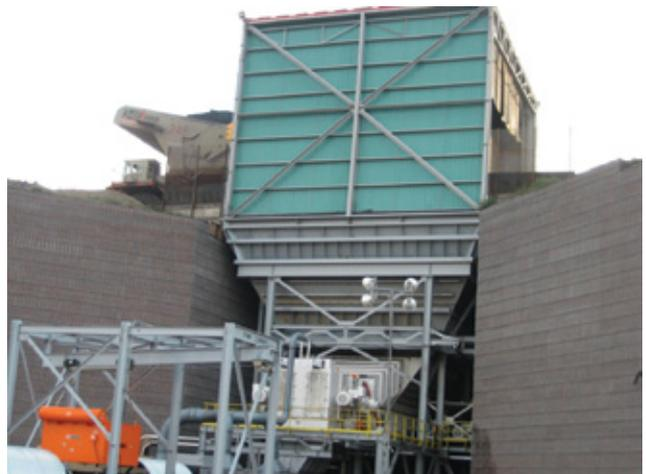
дробилки-питателя является то, что материал поступает горизонтально под дробильный вал. Бункерная установка ниже по высоте, чем другие виды дробилок, а это снижает общий объем капиталовложений, включая стоимость с учетом монтажа. Поскольку материал подается горизонтально цепным механизмом подачи, существует возможность включить питатель в обратном направлении, чтобы удалить любые оставшиеся недробленными куски, что является еще одним уникальным преимуществом.
