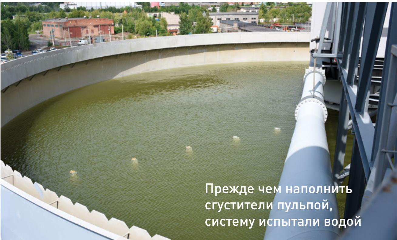
Прежде чем наполнить сгустители пульпой, систему испытали водой
