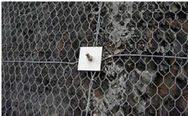
Рис. 8. Анкерное крепление в месте пересечения продольного и поперечного каната «Стилгрид® ВО»
