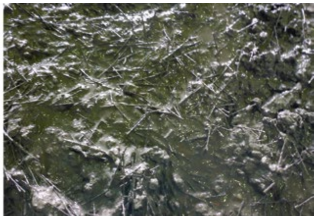
Фото 13. Нанесенная бетонная оболочка (слева со стальной фиброй, справа — с полимерной)
