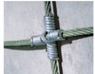
Рис. 9. Высокопрочный узел канатной HEA-панели
