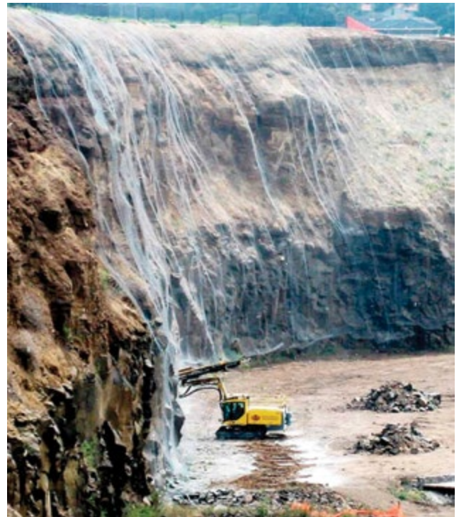
Рис. 2. Простая драпировка («Стилгрид HR»). Карьер Нидри, Австралия
