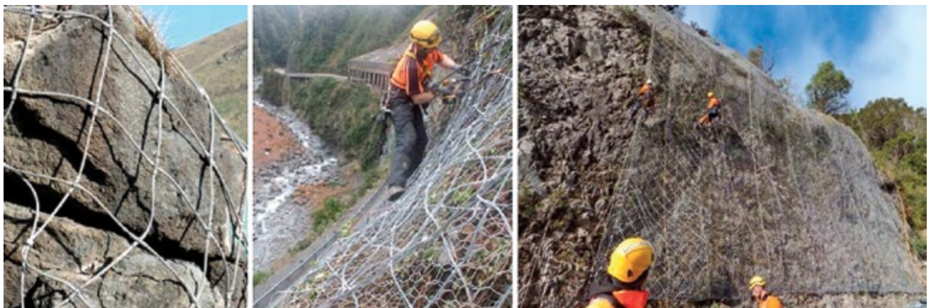
Рис. 10. Применение HEA-панелей на сильнотрещиноватых склонах
