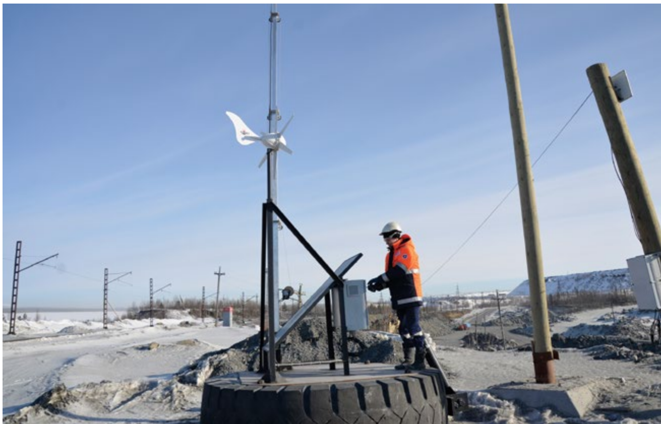
Комплексы для питания системы высокоточного позиционирования VIST работают на энергии ветра и солнца
