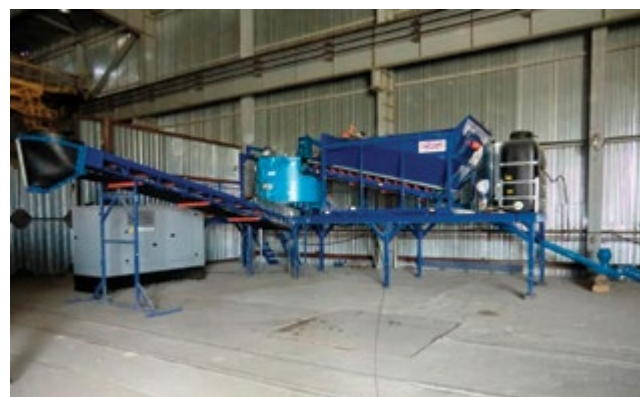
Фото 6. Бетоносмесительная установка, тип HA MP 1125/750 SM, фирма HARTMANN (www.hartmann-betonmischanlagen.de)
