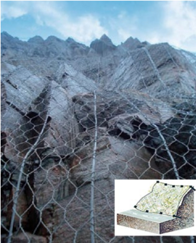
Рис. 3. Простая драпировка склонов
