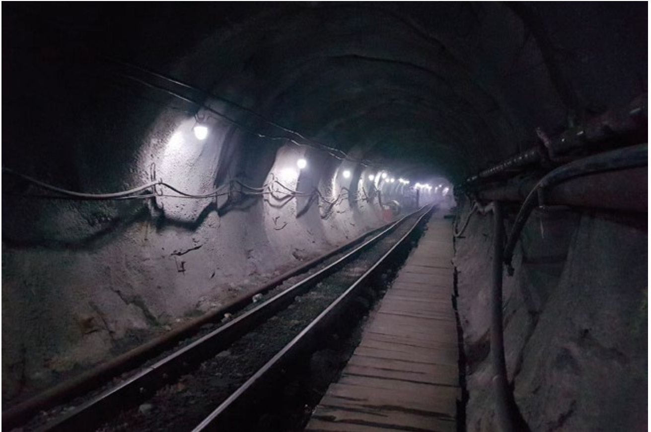
Фото 14. Готовый штрек, включая колею и водоотливную канаву (справа, покрыта)
