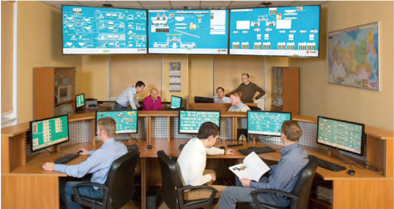
Рис. 1. Объединенный центр управления предприятиями, использующими оборудование и технологии НПО «РИВС»
