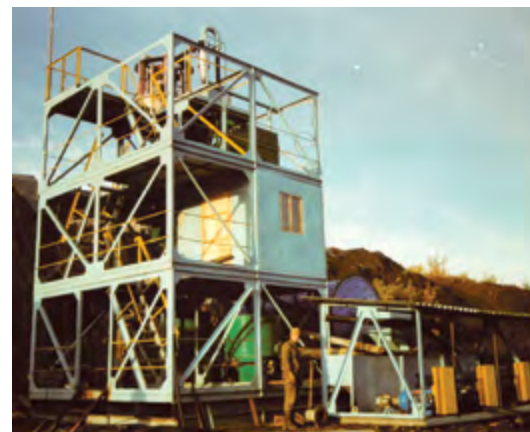
Монтаж модульной фабрики на месторождении Мальдяк
