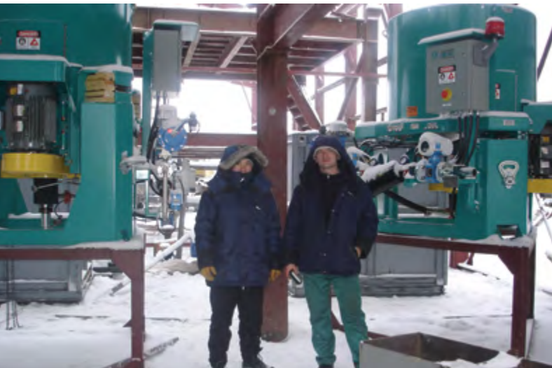
Монтаж в зимних условиях
