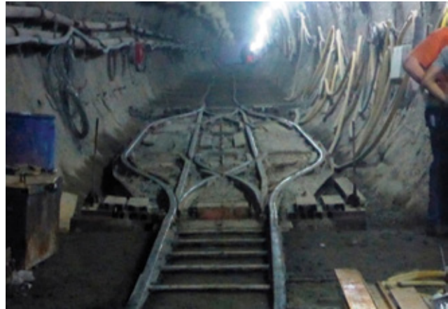
Фото 5. Трехходовая стрелка MASCHINENBAU MARK (www.maschinenbau-mark.de)
