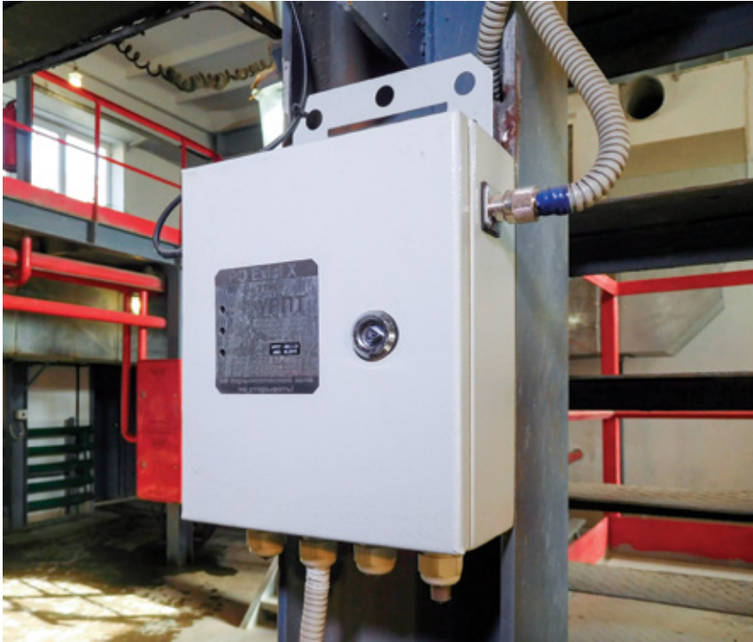
Устройство регистрации персонала и транспорта. Главная его функция — читать индивидуальные коды шахтеров
