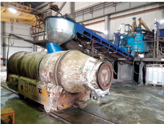
Фото 10. Миксер при наполнении фиброармированным бетоном
