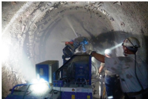
Фото 9. Манипулятор для набрызг-бетона, тип ORUGA компании MEYCO (www.atlascopco.com)
