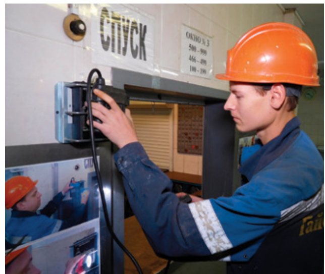
Перед спуском в шахту лампа каждого сотрудника подземного комплекса регистрируется в системе позиционирования
