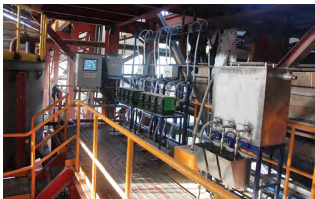
Автоматизированная установка дозирования реагентов «УДР-РИФ» на ОФ предприятия Carmen Copper Corporation
