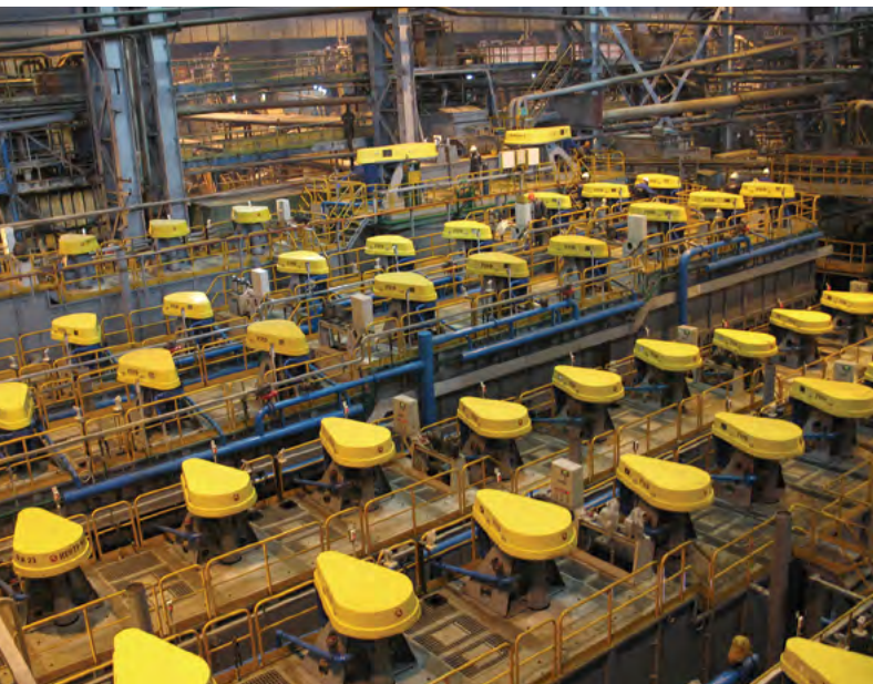
Реконструированная секция обогатительной фабрики МР КООП «Эрдэнэт»
