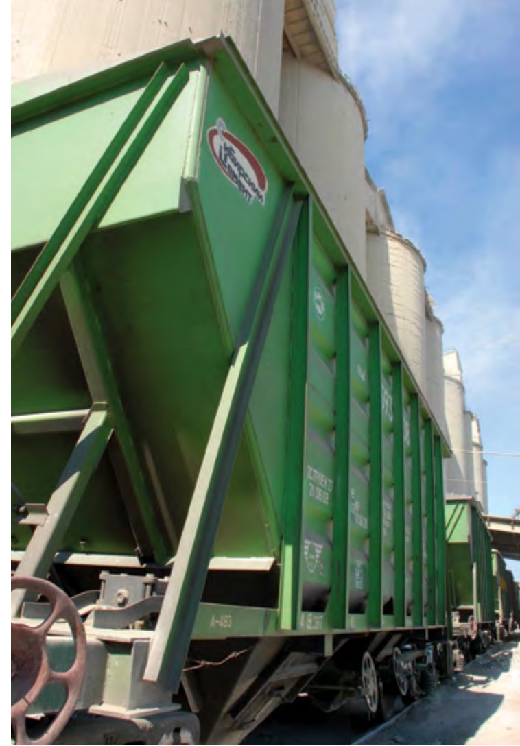
ООО «Топкинский цемент», цех «Готовая продукция»
