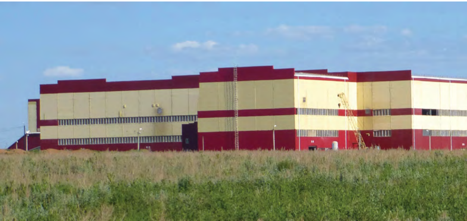
Рис. 4. Главный корпус обогатительной фабрики
