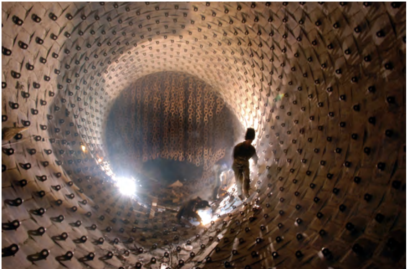
ООО «Топкинский цемент», цех «Обжиг». Работа футеровочной бригады в цепной зоне вращающейся печи
