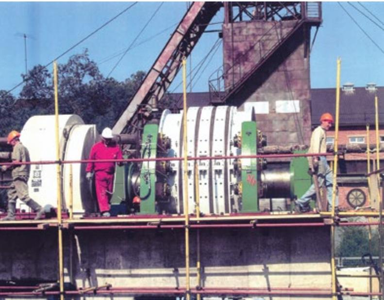
Рисунок 2. Монтаж многоканатной подъемной машины
