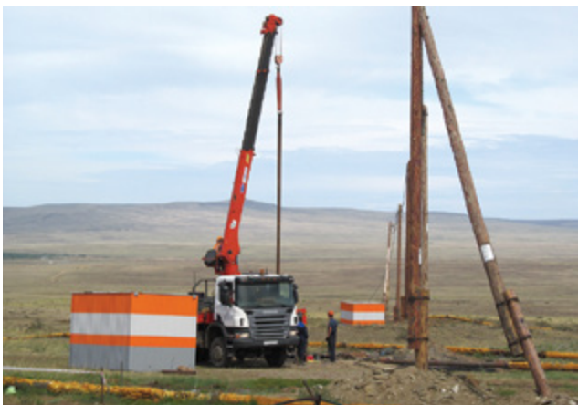
Рис. 6. Монтаж погружного насоса в скважину
