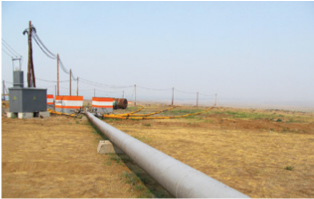
Рис. 2. Водоотводной коллектор от группы дренажных скважин
