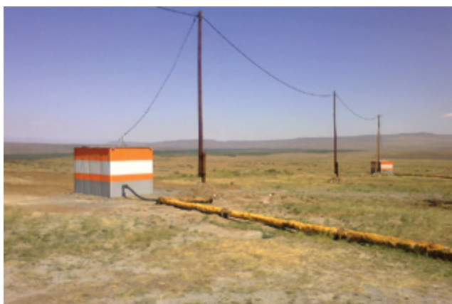
Рис. 1. Надскважинные павильоны дренажных скважин
