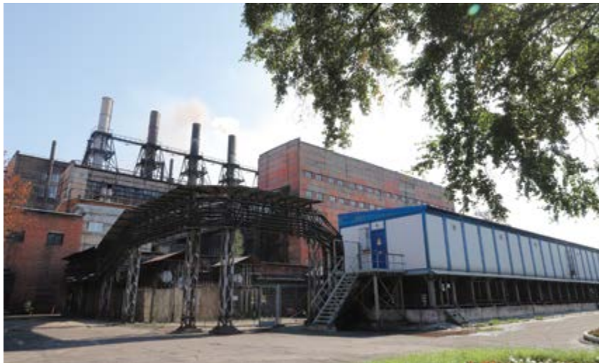
ЦОФ «Кузнецкая» расположена в Заводском районе Новокузнецка
