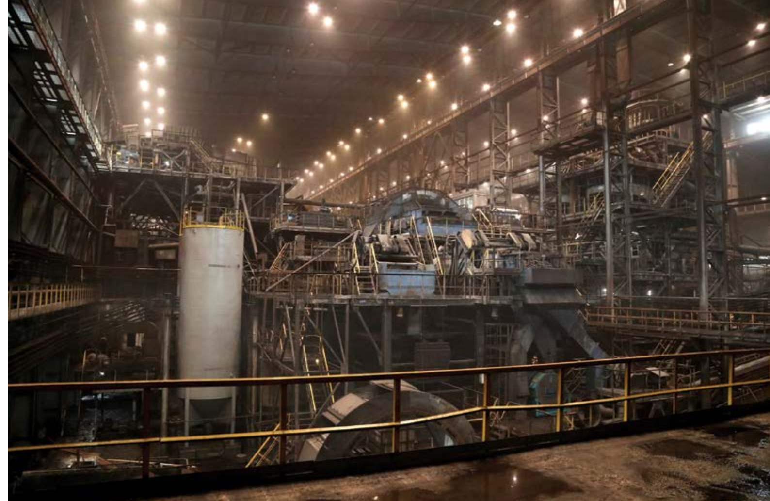
| Производственный корпус ОФ «Распадская»
