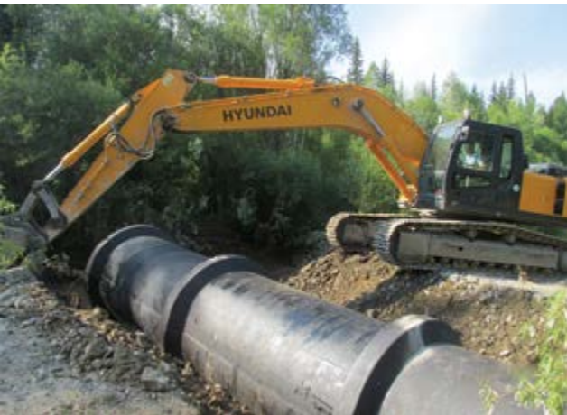
Строительство подъездной дороги к руднику
