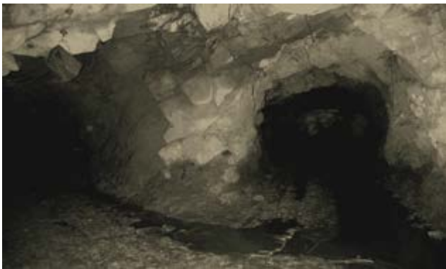
Сопряжение горных выработок (гор. 475 м)
