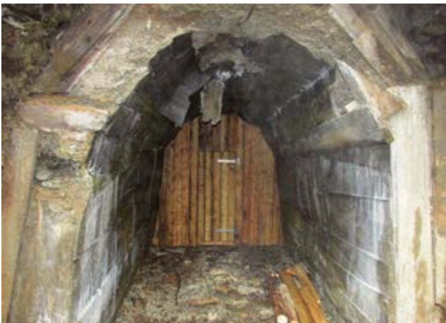
Устье вентиляционного уклона
