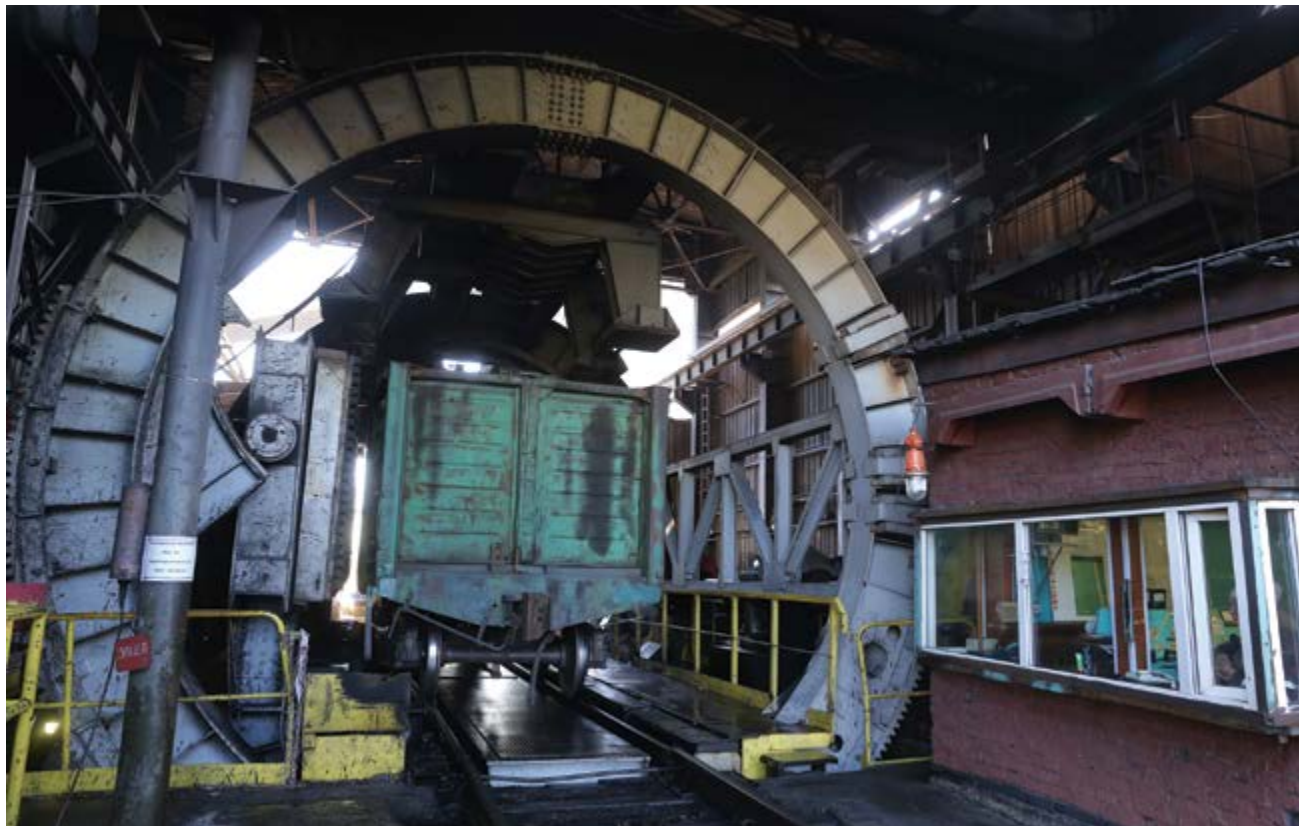
ЦОФ «Абашевская», участок погрузки и углеприема. Рядовой уголь с ж/д составов выгружается с помощью вагонопрокидывателя
