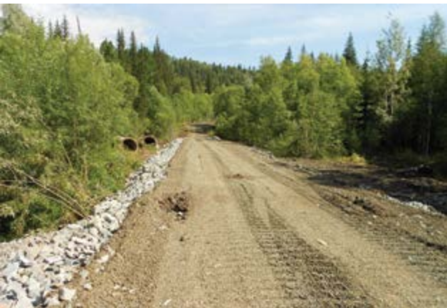
Подъездная дорога к руднику
