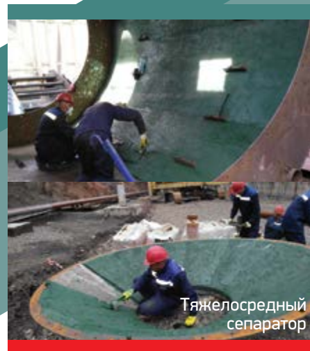
Футеровка технологического зумпфа
