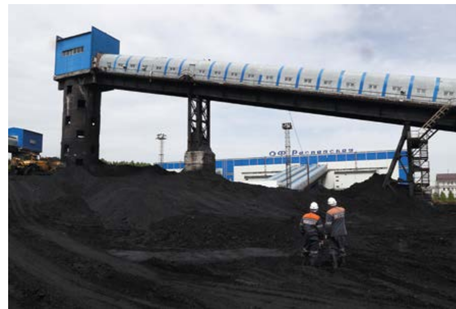
| Уголь с шахты «Распадская» поступает на фабрику по галерее
