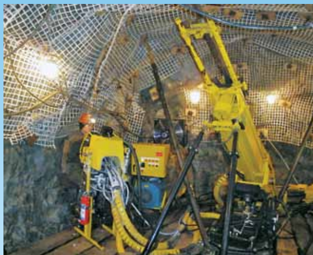
Diames 262 в подземной буровой камере
