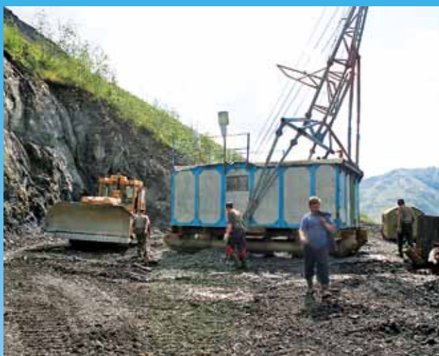
Монтаж буровой установки
