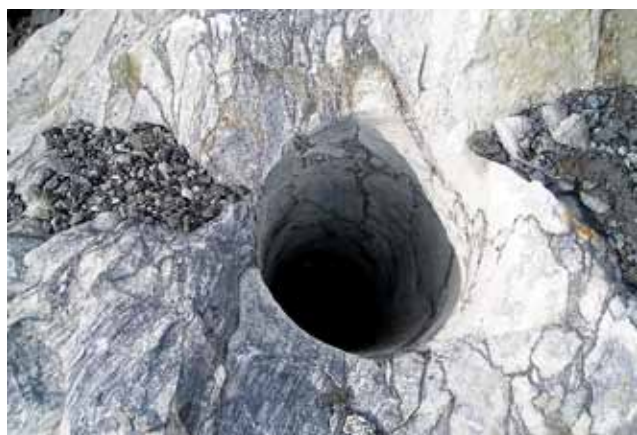
Шлам и скважина пневмоударного бурения
