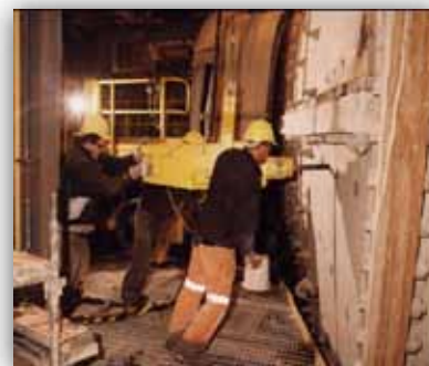
Пневмомолоты для выбивания болтов при демонтаже отработанной футеровки
