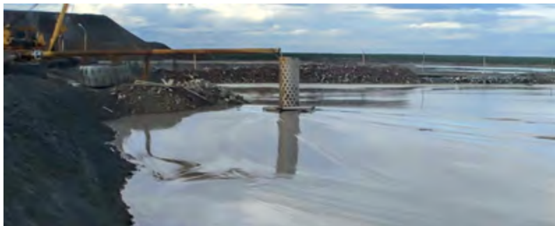
Рис. 1. Пример конусного складирования тонкодисперсных глинистых хвостов
