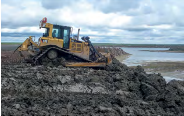
Рис. 3. Формирование отвала обезвоженных глинистых хвостов
