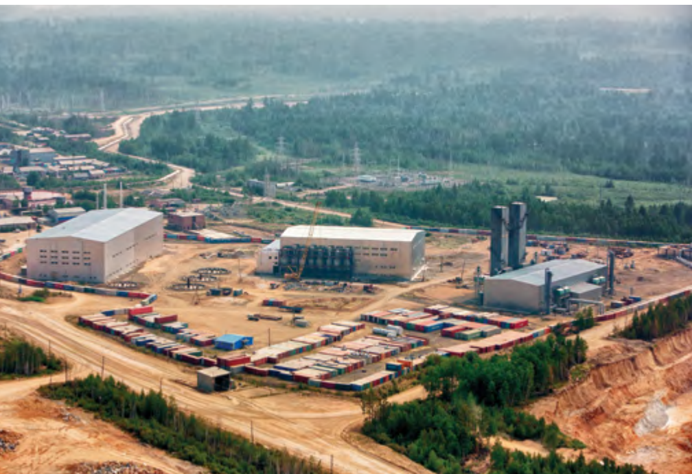
Корпуса Покровского автоклавно-гидрометаллургического комбината, Амурская область
