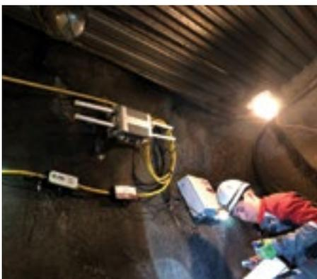
Рис. 4. Оборудование системы Centriam, точка доступа Wi-Fi на излучающем кабеле в подземных выработках рудника Долинный, «Казцинк»
