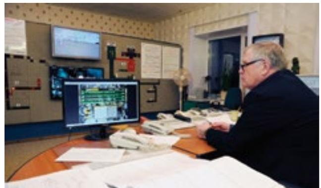
Данные мониторинга аэрогазовой обстановки и местоположения шахтеров в режиме онлайн будут поступать на пульт горного диспетчера
