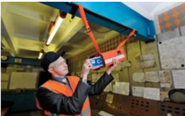
Блоки приема-передачи выступают в роли роутеров, обеспечивающих подземную беспроводную связь
