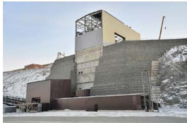
Рис. 10. Подпорная стена на завершающей стадии строительства
