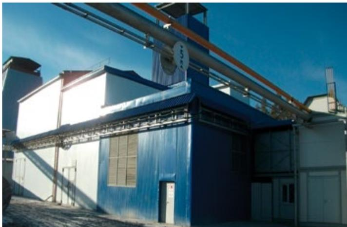
Рисунок 1. Вентилятор ГВУ (ВО-28АР/16 АР) с ПНВ на одном из рудников ОАО «УГМК», стандартное отработанное решение
