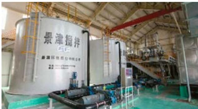
Рис. 5. Станция дозирования флокулянта
