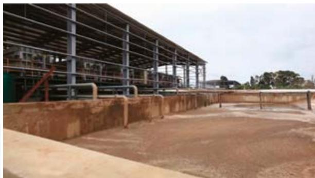
Рис. 22. Лагуна с поднятым осадком
