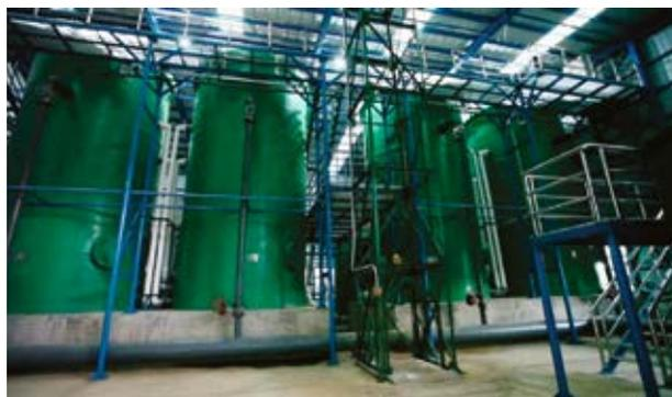
Рис. 25. Фильтры водоподготовки
