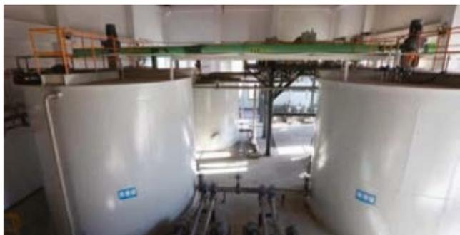
Рис. 13. Станция дозирования флокулянта
