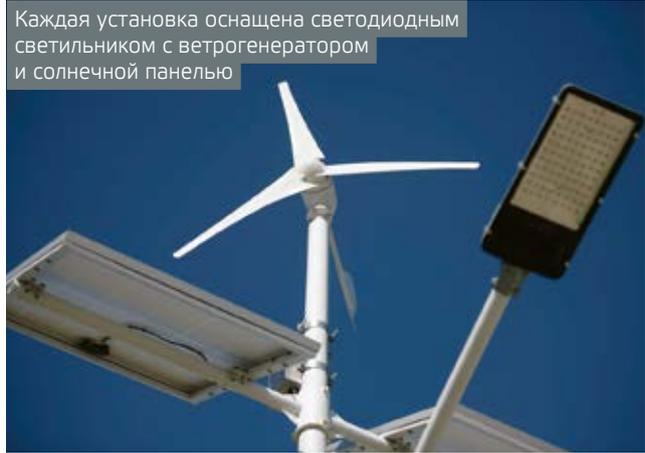
— Первый опыт показал, что установки работают эффективно, легки в монтаже и в дальнейшей эксплуатации. Поэтому было решено увеличить количество автономных опор. Возможно, в дальнейшем будем выводить определенные участки на полную генерацию от солнечных панелей, — рассказал начальник электролаборатории АГМК Даниил Хирвонен.
