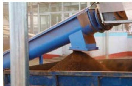
Рис. 42. Отгрузка высушенного осадка
