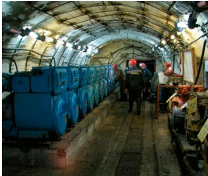
Рис. 5. Распределительное устройство 6 кВ, выполненное на ячейках УК-6 (слева)
