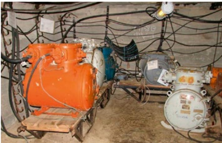
Рис. 4. Распределительный пункт напряжением до 1 000 В
