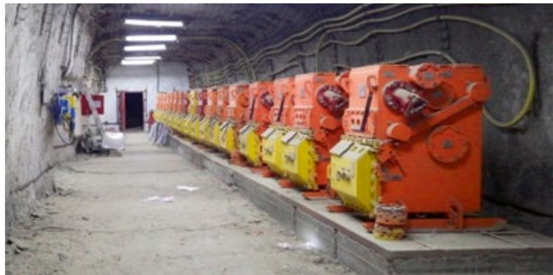
Рис. 11. Распределительное устройство 6 кВ, выполненное на ячейках КРУВ-6М
