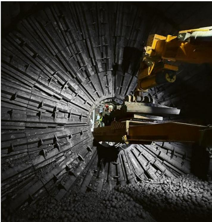
(МПСи). Особенностью футеровки является снижение веса по сравнению с бронями из хромомолибдена. Масса футеровочных элементов Argmoliner меньше на 50–60 тонн. При этом защитные свойства полностью сохраняются: износостойкие элементы в данной конструкции демпфируют, гасят ударные нагрузки, тем самым снижается износ самой футеровки до 20 %. Таким образом, эксплуатационный ресурс
